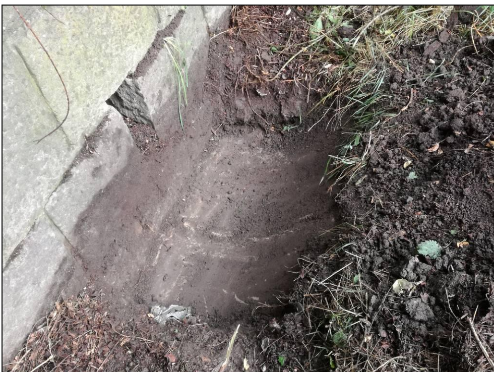
Obr. č. 8 - pohled na zanesené (nefunkční) odvodňovací žlaby, které svádí vodu podél opěrné zdi směrem k zastávce Velká Chuchle
