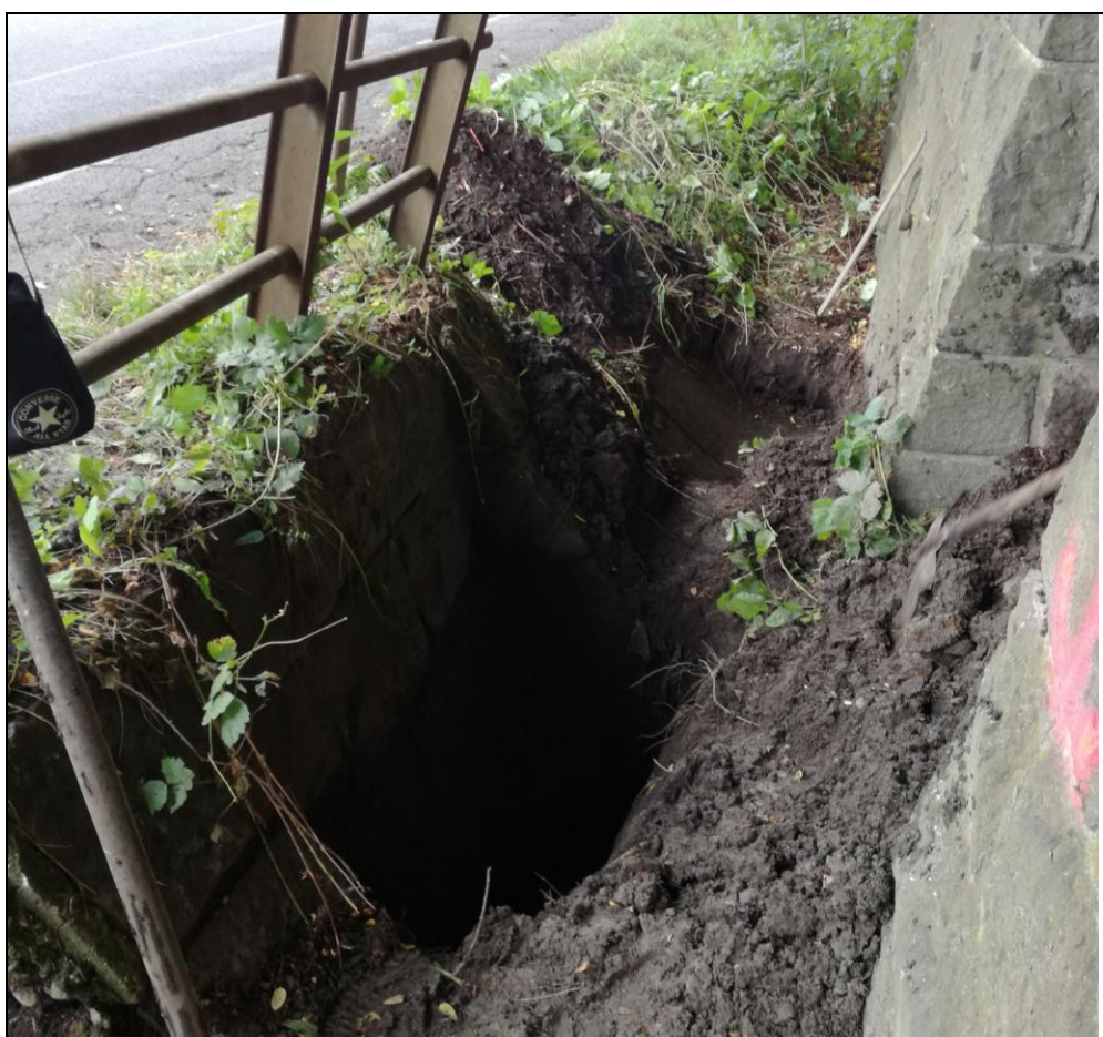
Obr. č. 6 - kopaná sonda pro ověření funkčnosti přilehlého propustku, který podchází silniční komunikaci v ulici Radotínská
